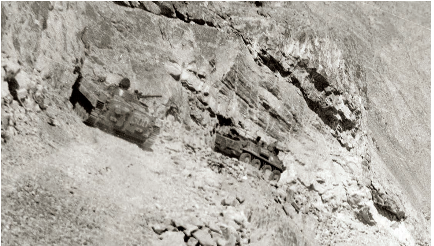
На марше при проведении Тергиранской операции в Вардуджском ущелье
